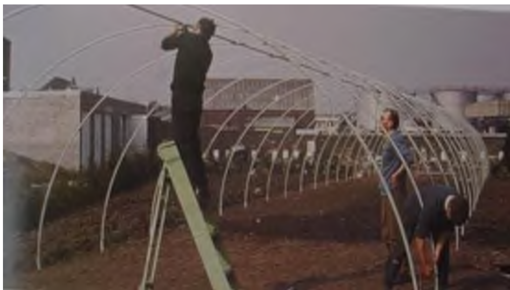
Hình 2.9: Lắp ráp bộ khung nhà kính dạng ống (tube)
