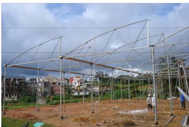
Hình 2.14: Bộ khung nhà kính đã hoàn thành.
