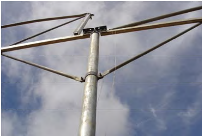
Hình 2.11: Lắp đặt các thanh rui và cột chống vào trụ chính.
