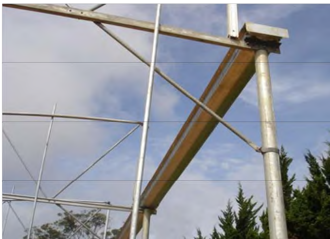
Hình 2.13: Máng thoát nước (xối) được lắp bên hông nhà kính.
