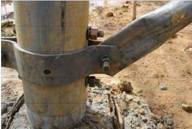
Hình 2.10: Lắp các cột chống đỡ vào trụ chính.
